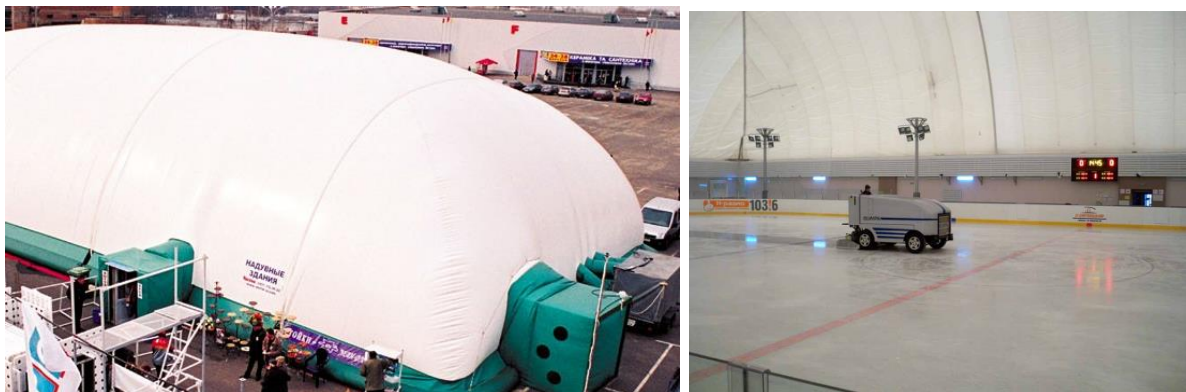
Рисунок 1. Примеры ледовых площадок на основе быстровозводимой конструкции воздухоопорного типа с синтетическим льдом
