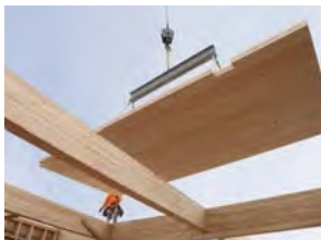
Строительство из CLT-панелей
