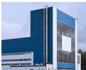
Основной производственный корпус
